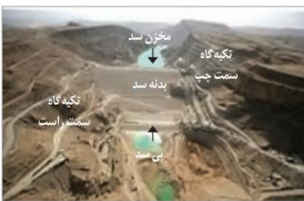
نمایی از بخش‌های مختلف یک سد
